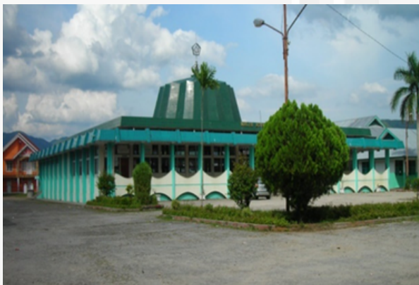
Masjid Agung yang dibangun pada tahun 1984
